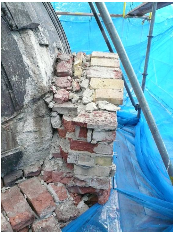
Till vänster, skador på murkrön och risalit i anslutning till betongkupolen; under den borttagna plåttäckningen.
