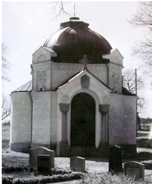
Foto av koret år 1951. Ljus kulör på de stora väggytorna; grå sandstenskulör på detaljerna i portalen; svart färgsättning på kupol, plåttäckta ytor och stuprör. Foto ATA.
