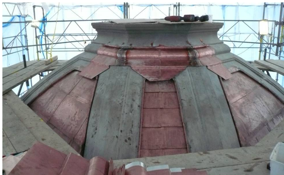
Några ögonblick från plåtarbetena. Betong- och putsade ytor på överdelen av byggnaden behandlades först med ett cementbaserat tätskikt.
