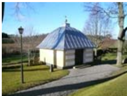
B 08 – Bårhuset uppfört 1926 fr. SO
