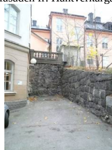
Norra fasaden med stödmurarna
