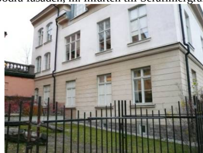
Västra fasaden fr. Hantverkargatan i SV
