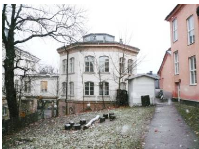
Byggnaden fr. N
