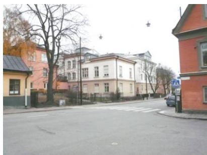
Byggnaden sedd fr. Kungliga Mynt, fr. SV
