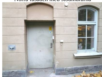
Fönster omvandlat till dörr i norra fasaden
