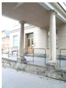
Östra fasaden med rampen och bron
