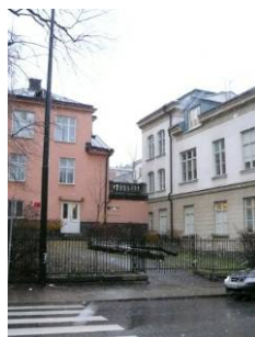
Västra fasaden fr. Hantverkargatan i SV
