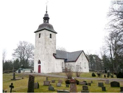
B 05 – Kyrkan med sidokoret mot södra långväggen; fr. SV
