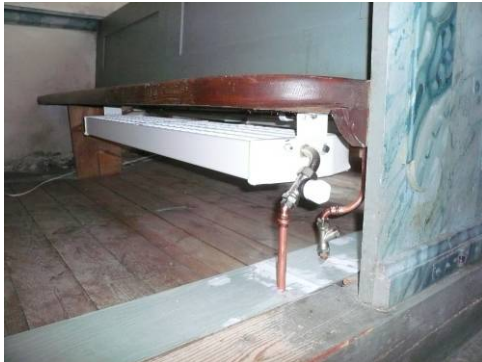
Värmekonvektor och röranslutning under en bänkarna i södra kvarteret.
