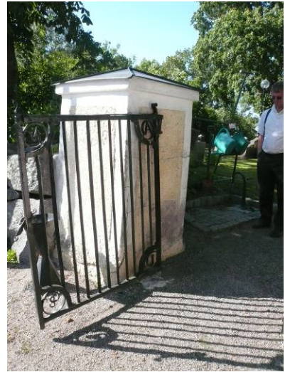
Underhåll av grindar och restaurering av grindpelarna
