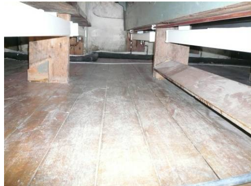
Värmekonvektor och röranslutning under en bänkarna i södra kvarteret.
