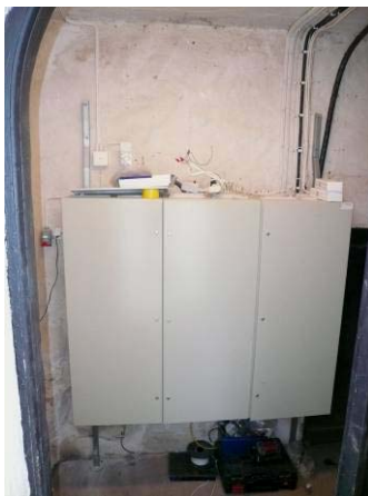
Den nya elcentralen i gamla pannhuset (sakristian). Strömbrytare och elkontakter av serien Eljo Renova. Utrymningsskylten placerades på orgeln, i anslutning till den enda utgången.
