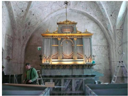
Ny elinstallation och uppdatering av vissa armaturer och komponenter
