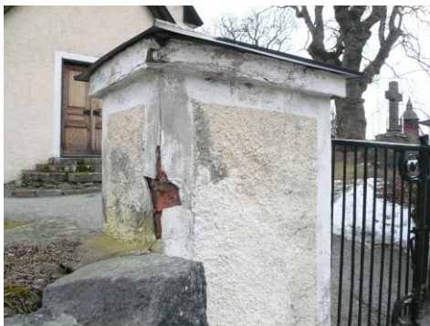
Pelare och grind vid södra ingången, före åtgärd. De renoverade pelarna vid södra ingången.
