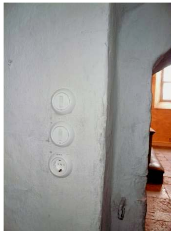
Den nya elcentralen i gamla pannhuset (sakristian). Strömbrytare och elkontakter av serien Eljo Renova. Utrymningsskylten placerades på orgeln, i anslutning till den enda utgången.
