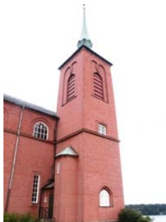
B 08 – Tornet på södra sidan
